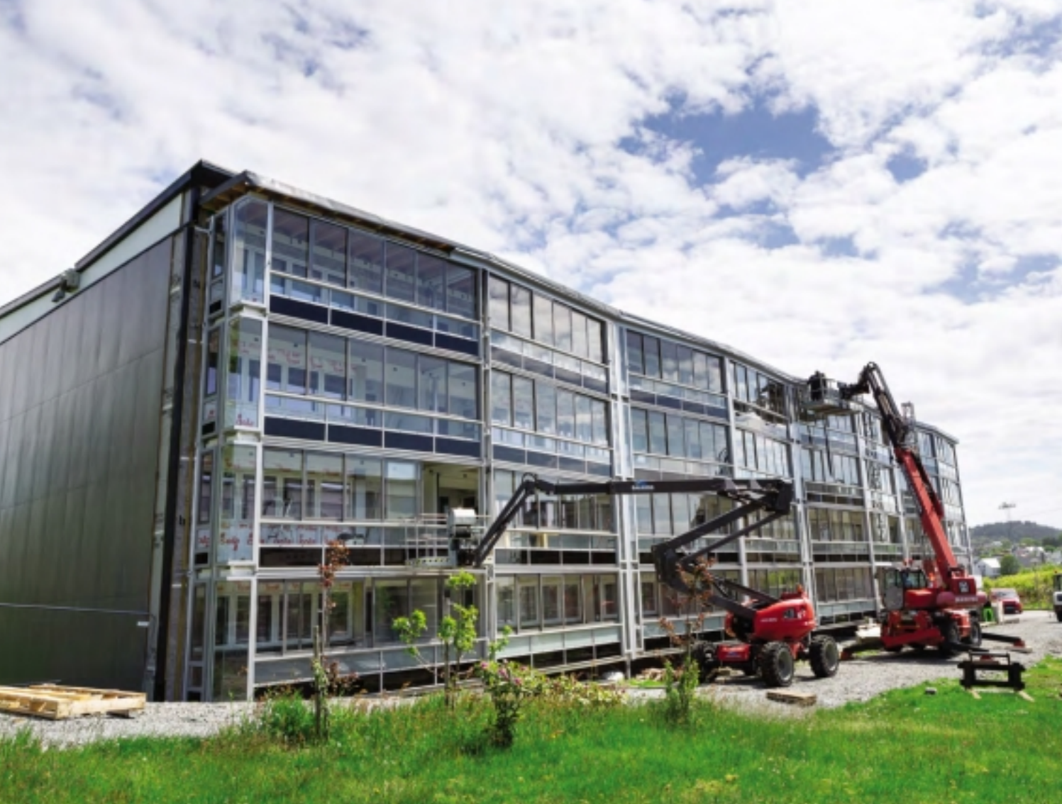
INNGLASSET. Skeisvang borettslag i Haugesund oppgraderer denne våren fasadene med innglassede balkonger.
